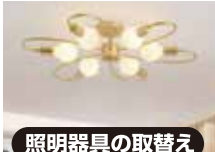
照明器具の取替え
